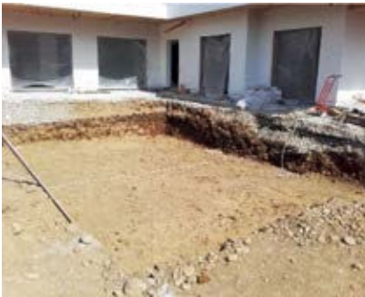
1. TRACCIARE PERIMETRO ED ESEGUIRE LO SCAVO
