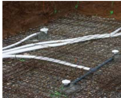
2. ARMARE PLATEA CON RETE ELETTROSALDATA
